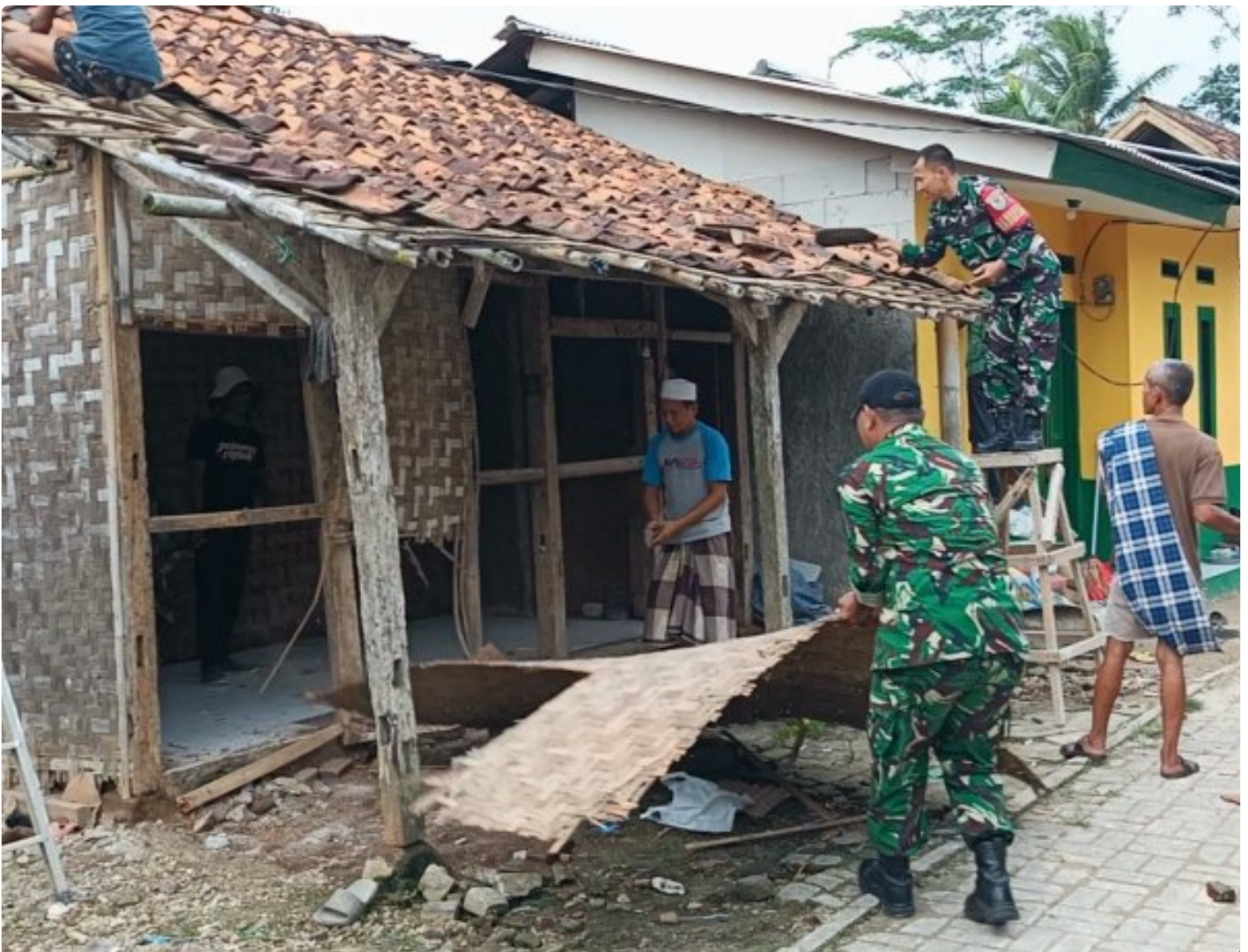
Pembongkaran Rumah Bapak Narmin
