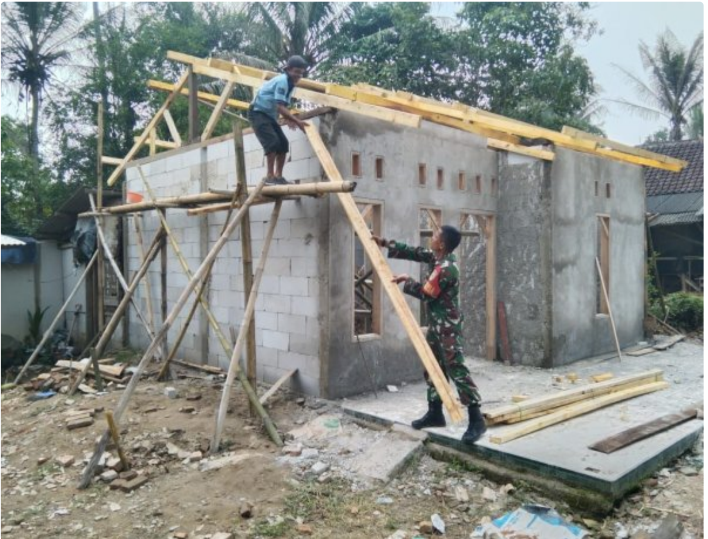
Serda Naya membantu pemasangan atap RTLH
